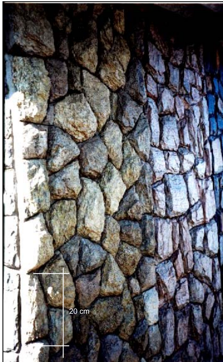
FOTO 70 - REVESTIMENTO DE PAREDE COM DOIS TIPOS DE XISTOS: O DA DIREITA, MICA XISTO ROSADO ("PEDRA MADEIRA ROSA"); O DA ESQUERDA, QUARTZO XISTO AMARELO-ESVERDEADO ("PEDRA MADEIRA VERDE ABACATE") - BOTUCATU, SP
