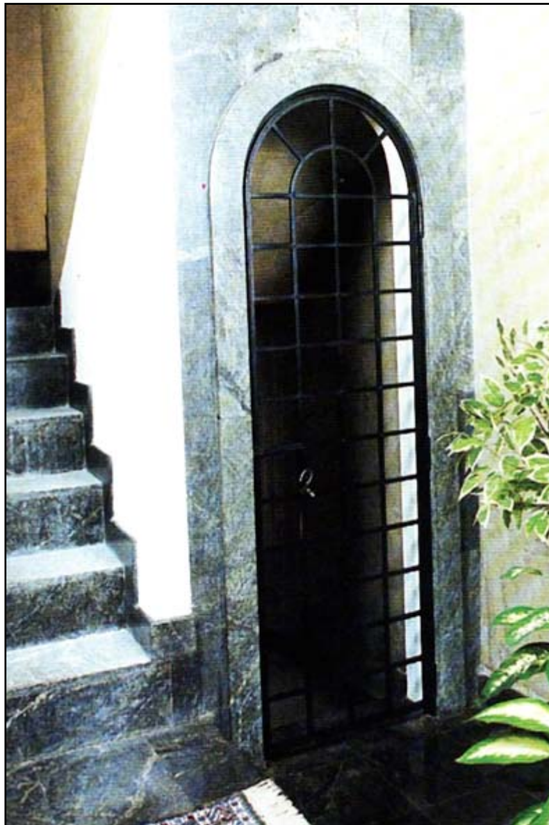
FOTO 72- UTILIZAÇÃO DE TALCOXISTO ("PEDRA SABÃO") COMO REVESTIMENTO DE DEGRAUS DE ESCADA E ORNAMENTAÇÃO DE BATENTE DE PORTA. DEVIDO À SUA BAIXA RESISTÊNCIA À ABRASÃO, A UTILIZAÇÃO COMO PISOS É RECOMENDADA SOMENTE EM ESCADÁRIAS DE TRÁFEGO MUITO RESTRITO - BOTUCATU, SP
