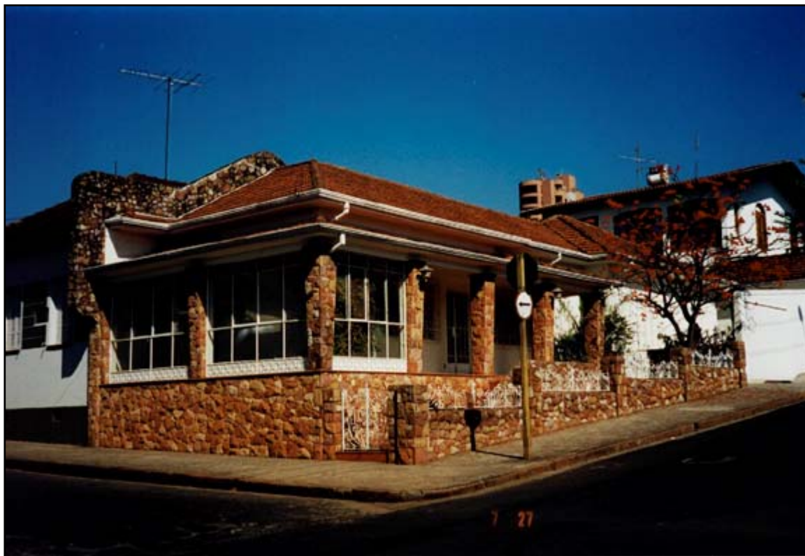
FOTO 48 - UTILIZAÇÃO DE BLOCOS IRREGULARES APARELHADOS DE ARENITO SILICIFICADO EM FACHADA RESIDENCIAL - BOTUCATU, SP (Extraído de IAMAGUTI, 1998)
