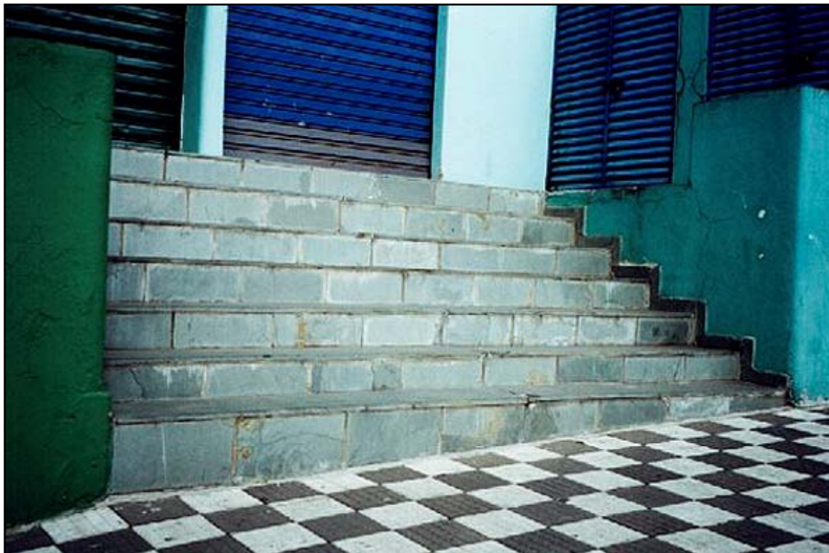
FOTO 52 - UTILIZAÇÃO DE PLACAS DE ARDÓSIA VERDE (15x30 cm) EM ESCADARIA - BAURU, SP
