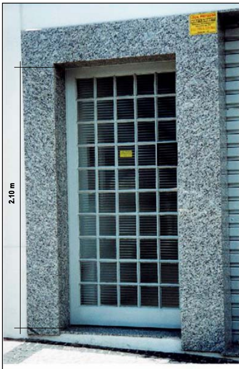
FOTO 42 - UTILIZAÇÃO DE GRANITO (PLACAS POLIDAS, 20x30 cm) EM AMBIENTE EXTERNO - BOTUCATU, SP
