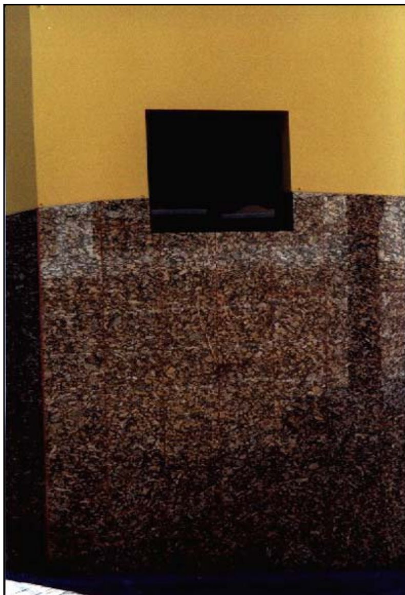
FOTO 38 - PAREDE EXTERNA DE LABORATÓRIO MÉDICO REVESTIDA COM PINTURA AMARELA E PLACAS POLIDAS (30x30 cm) DE DIORITO EQUIGRANULAR - BOTUCATU, SP
