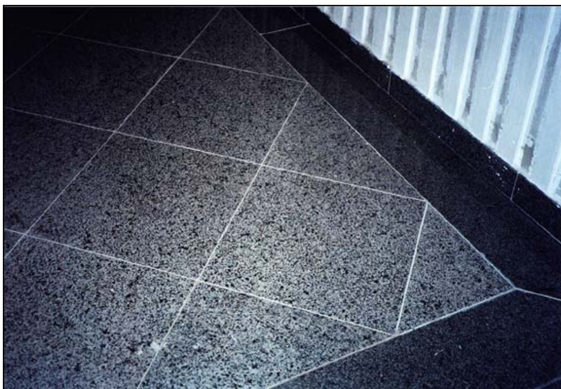
FOTO 43 - AMBIENTE INTERNO (HALL DE ELEVADOR) REVESTIDO COM PLACAS POLIDAS CLARAS DE GRANITO (30x30 cm) E BORDAS DE PLACAS ESCURAS DE DIORITO (10x60 cm) - BOTUCATU, SP (Extraído de IAMAGUTI, 1998)
