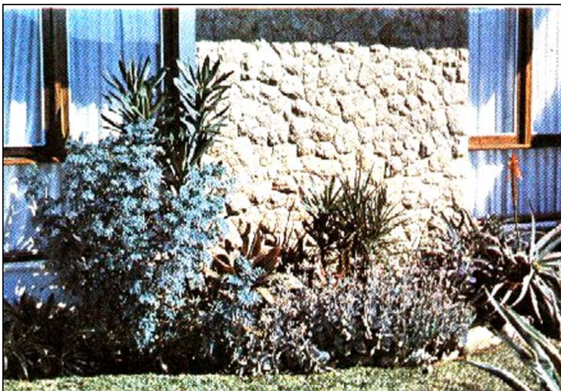
FOTO 50 - UTILIZAÇÃO DE PLACA DE CALCÁRIO (DIMENSÕES APROXIMADAS DE 12x14 cm), IRREGULARMENTE APARELHADAS, EM REVESTIMENTO DE FACHADA RESIDENCIAL - CURITIBA. PR
