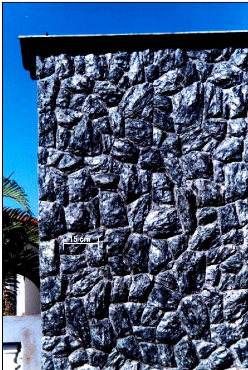
FOTO 71 - UTILIZAÇÃO DE MICA XISTO ("PEDRA MADEIRA GRAFITE") NO REVESTIMENTO DE MURO RESIDENCIAL - BOTUCATU, SP
