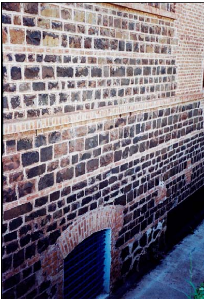
FOTO 35 - UTILIZAÇÃO DE BASALTO (BLOCOS COM DIMENSÕES NA MÉDIA DE 20X15 cm) EM PAREDE EXTERNA DE CASARÃO ANTIGO - BOTUCATU, SP
