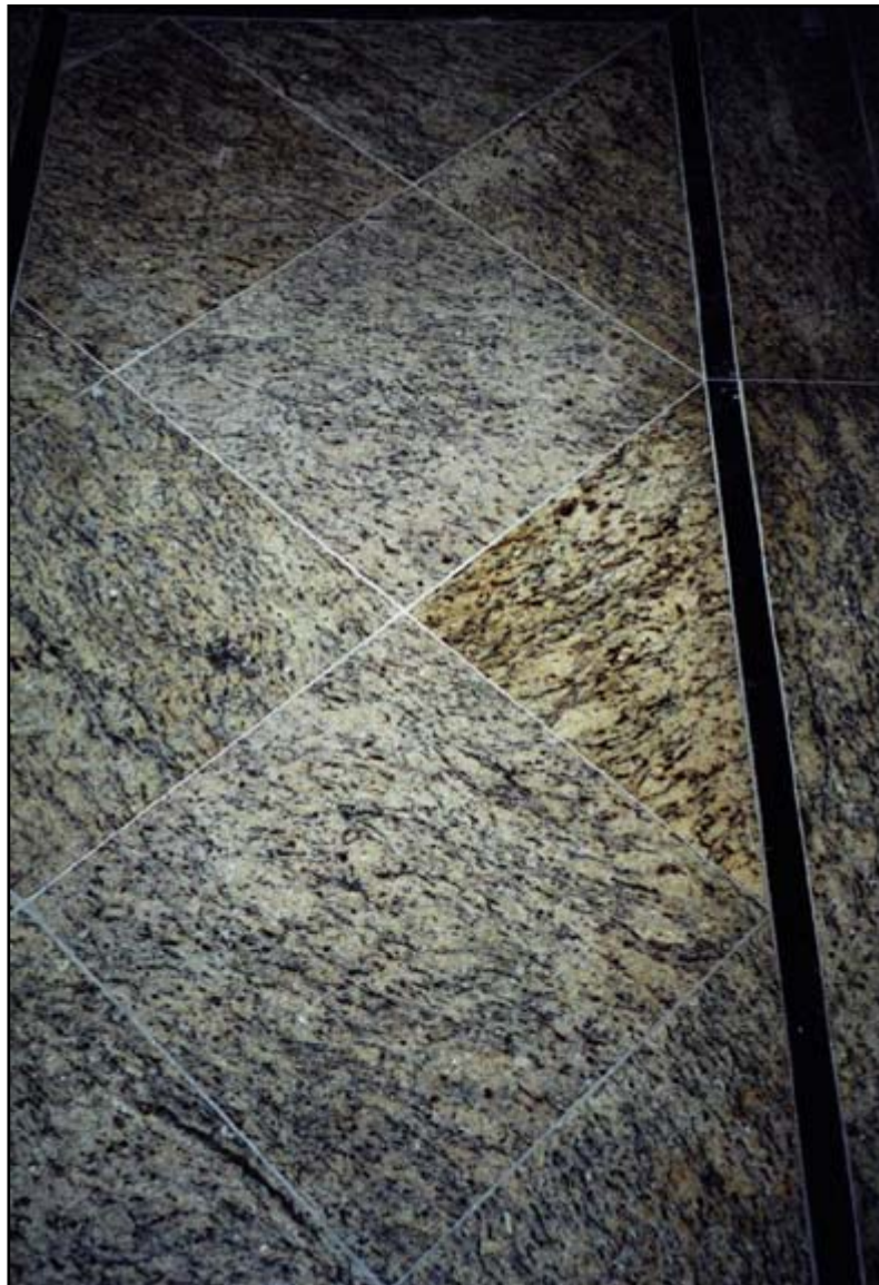
FOTO 55 - UTILIZAÇÃO DE PLACAS POLIDAS DE GNAISSE (30x30 cm) EM PISO DE COZINHA. OBSERVAR A COLORAÇÃO CASTANHA RESULTANTE DA ALTERAÇÃO DE MAGNETITA - BOTUCATU, SP (Extraído de IAMAGUTI, 1998)
