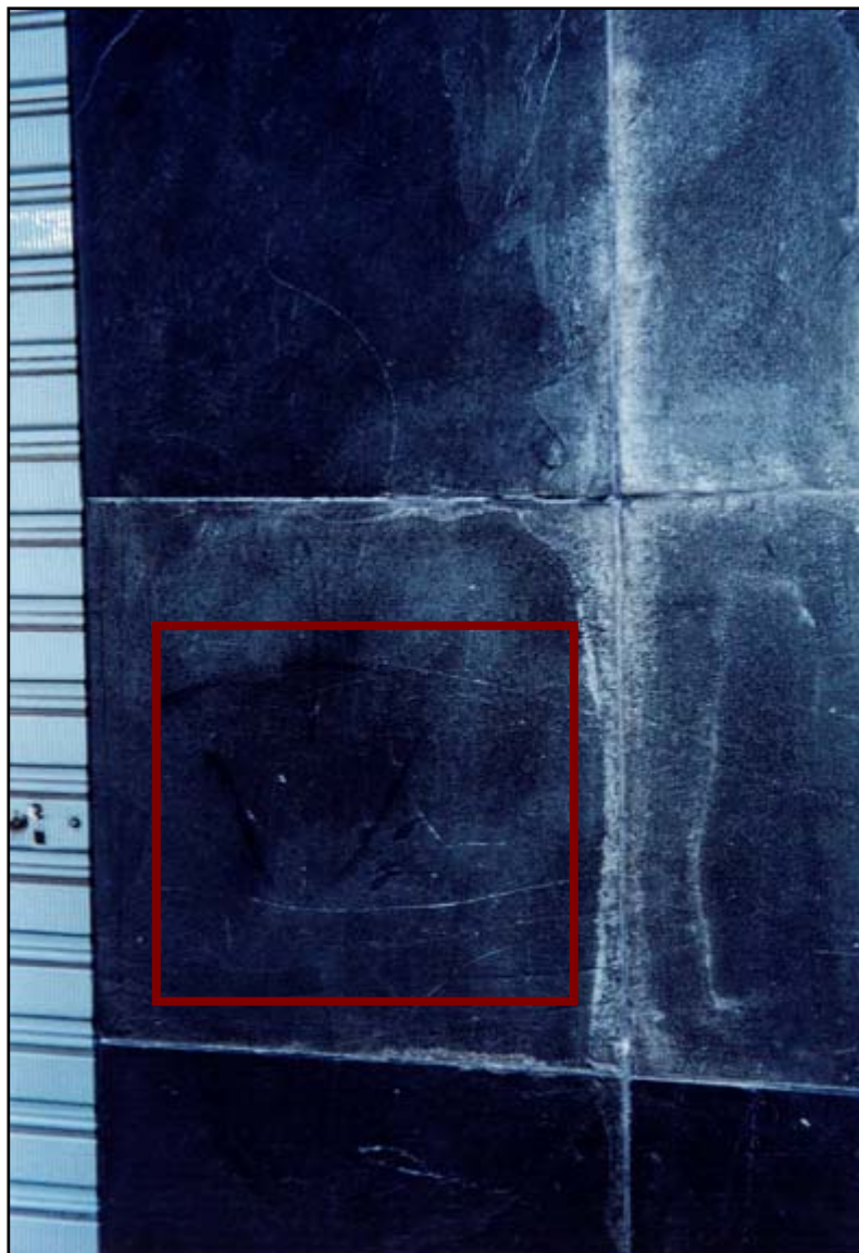
FOTO 1 - FOTO ILUSTRANDO PLACAS DE ARDÓSIAS (20X20 cm) APRESENTANDO RISCOS, QUE COMPROMETEM A ESTÉTICA DA OBRA (FACHADA COMERCIAL) - BOTUCATU, SP
